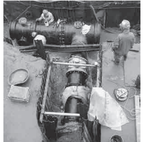
三郷中央地区内の配水管布設工事
