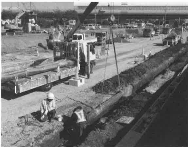
三郷中央地区内の配水管布設工事
