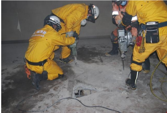
コンクリート壁 削岩訓練 (ブリーチング 左写真) 床面に開けた救 出口 (右写真)
