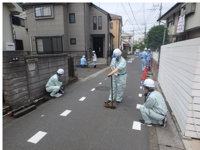
連絡管の操作確認
