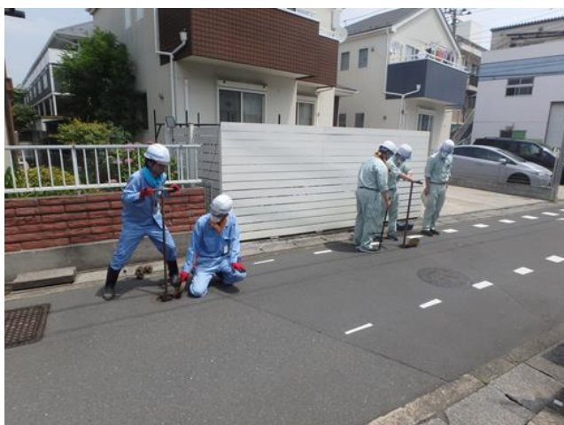
連絡管の操作確認
