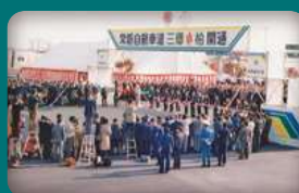
昭和60(1985)年 常磐自動車道と首都高速足立・三郷線が接続し供用開始
