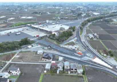
フルインター化に向けて工事中
