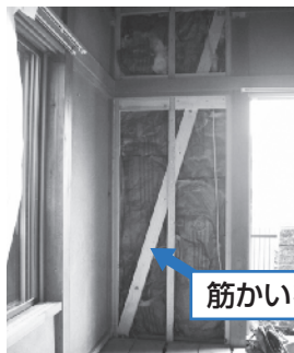
筋かいなどで補強し、震災に備えます (耐震診断・耐震改修等費用助成事業補助金)
