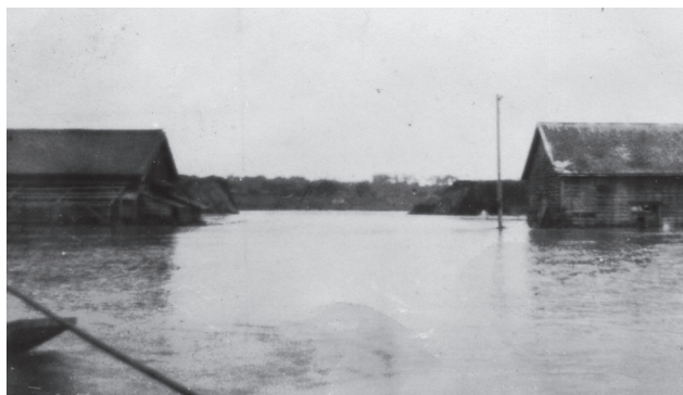
東町付近の浸水の様子
