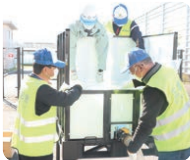
給水タンクの組み立て
