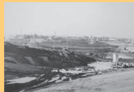
着工当時の三郷放水路(昭和49年)
