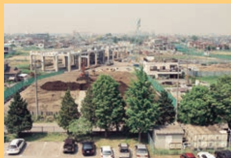
つくばエクスプレス工事風景(平成14年)
