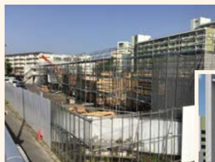
建設中の様子
