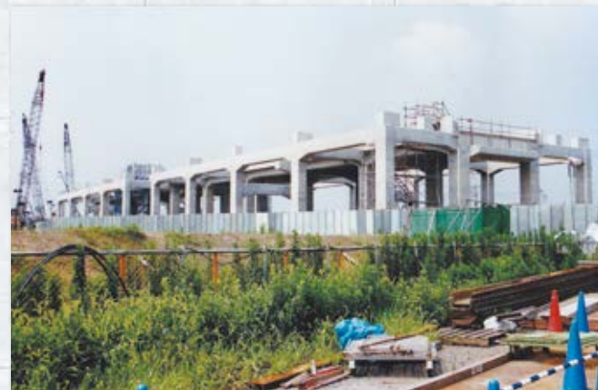
建設中の三郷中央駅(平成14年)
