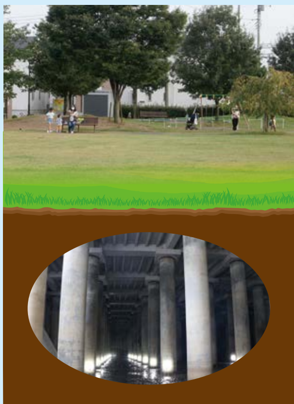
▲パルテノン神殿のような地下調整池
