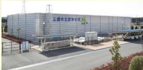
老朽化対策は大規模な水道施設にも必要です(写真は、耐震型ステンレス製に建て替えた北部浄水場配水池)。
