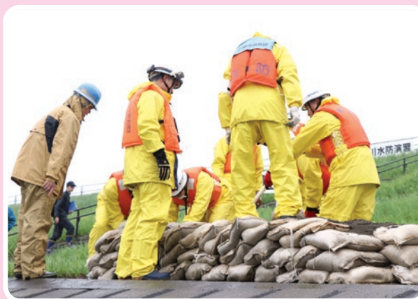
▲堤防に土のうを積み上げる水防団員(消防団員)たち
