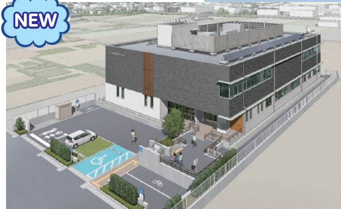
▲共同消防指令センター （越谷市大字大泊309番地1）
