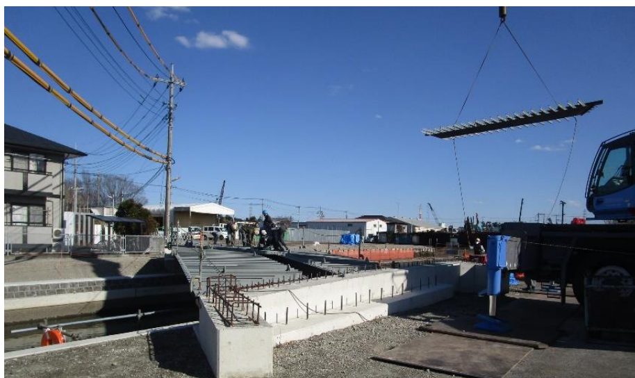
作業状況 (令和2年2月撮影)
