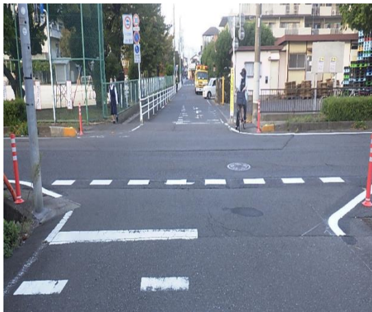
区画線の修繕
