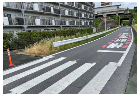
D : 道路の横断に危険性がある箇所
