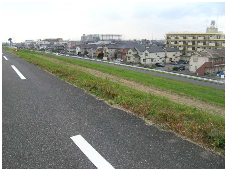
着手前(拠点盛土)
