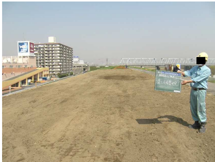
盛土完了(拠点盛土)
