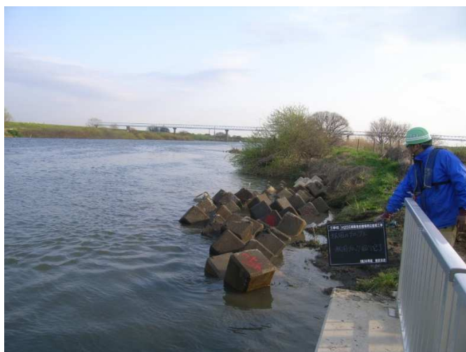
値固めブロック据付完了
