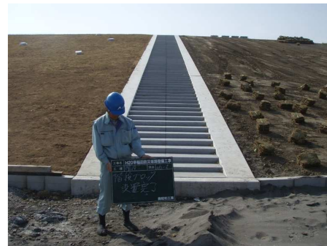
階段ブロック設置完了(上流側)
