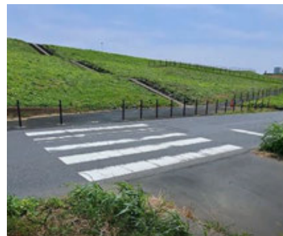
D : 道路の横断に危険性がある箇所
