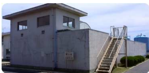
着水井・塩素混和池
