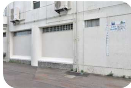
浸水対策壁(北部第二配水場)
