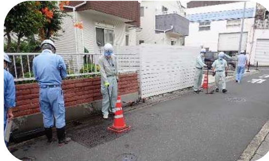
八潮市連絡管定期点検の様子
