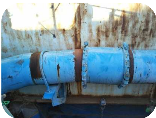
北側道橋添架管(左:補修前、右:補修後)
