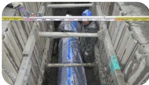
基幹管路更新工事の様子
