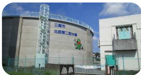
北部第二配水場
