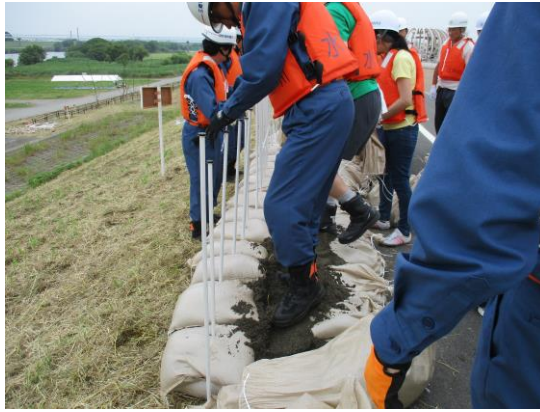
江戸川水防事務組合水防演習(積土のう)
