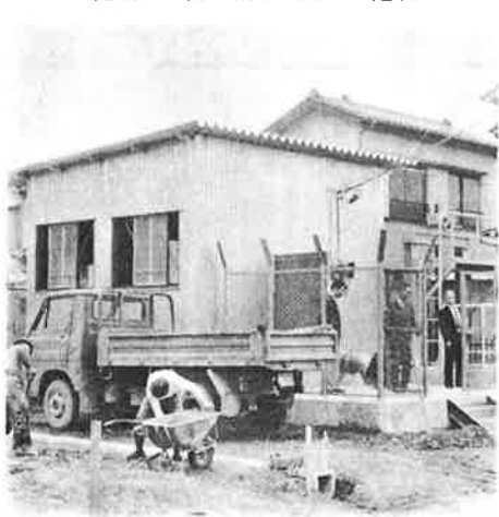
完成した排水機場（前面の建物）
