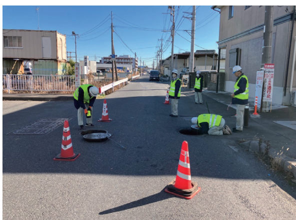
公共下水道の点検作業
