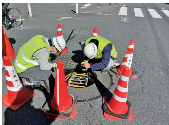
公共下水道の点検作業
