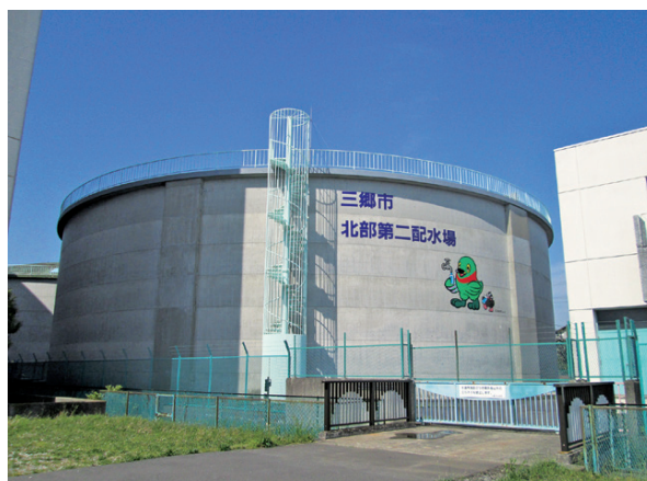
北部第二配水場
