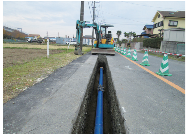
耐震管布設の様子
