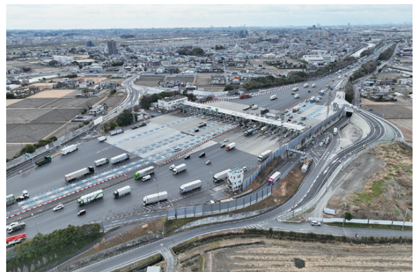
三郷料金所スマートインターチェンジ
