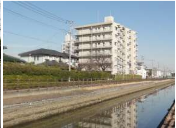
下第二大場川的环境に配慮した護岸整備 (寄巻)
