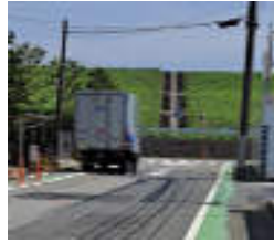
三郷駅からの河川敷へアクセスするための階段部
