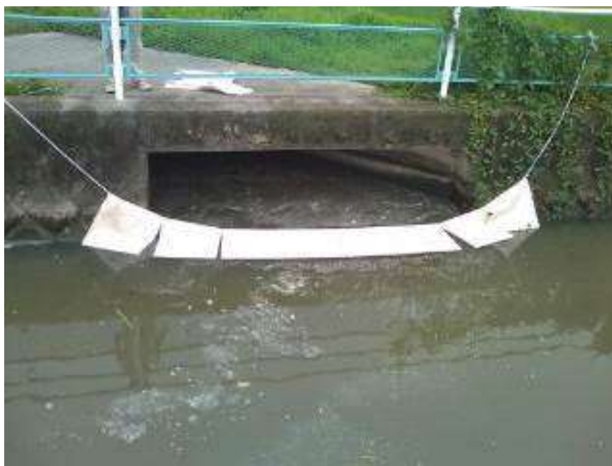
市排水路から油が第二大場川に流入しないよう吸着マットで流出防止
