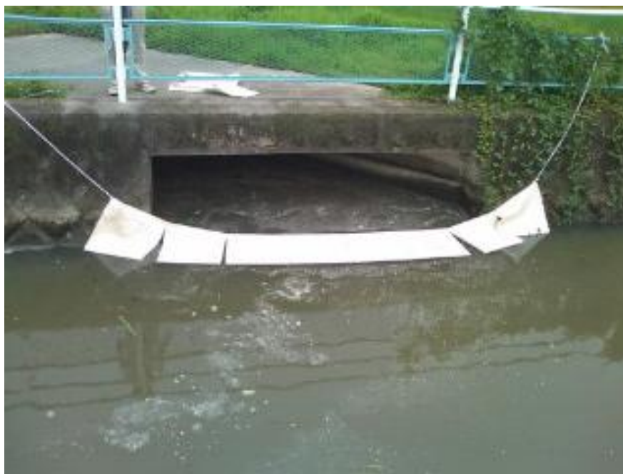
市排水路から油や生物膜が第二大場川に流入しないよう吸着マットで流出防止
