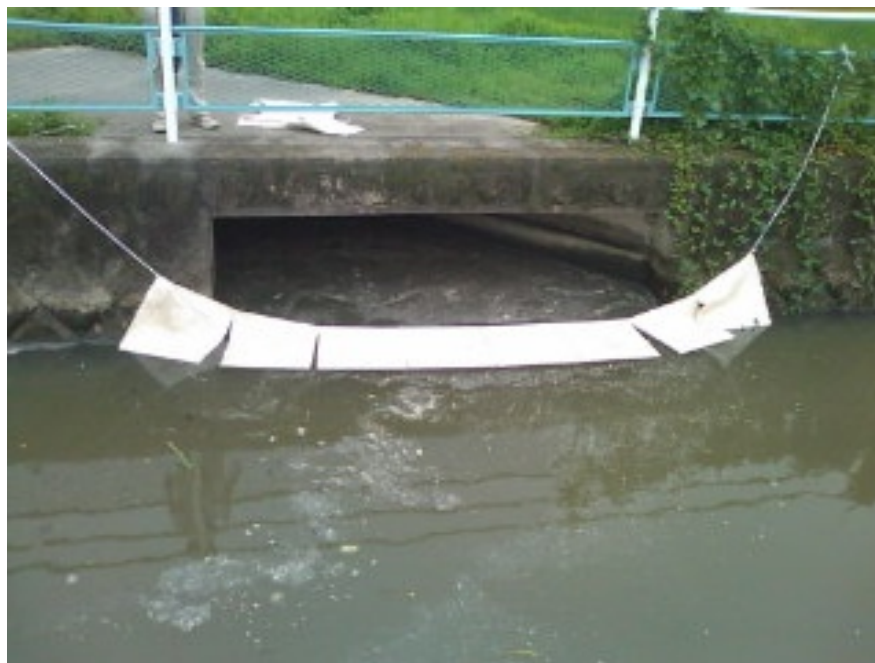
市排水路から油や生物膜が第二大場川に流入しないよう吸着マットで流出防止
