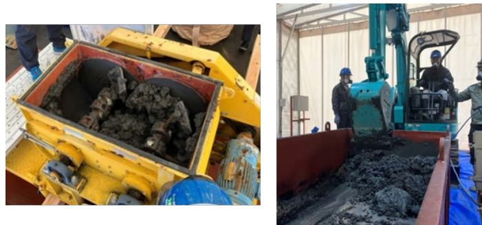
図 9 資材混合状況（左：小型攪拌装置、右：小型バックホウ）(No. S4)
