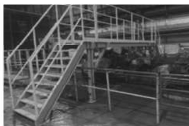
安全化対策工事(設計・製作・据付)
