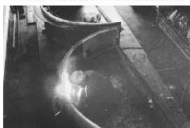
製缶加工・鉄部補修工事
