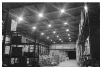
LED化工事(蛍光灯～大型灯具対応)
