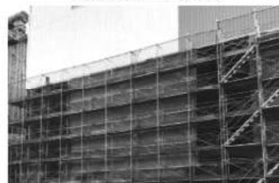
建屋屋根・外壁工事
