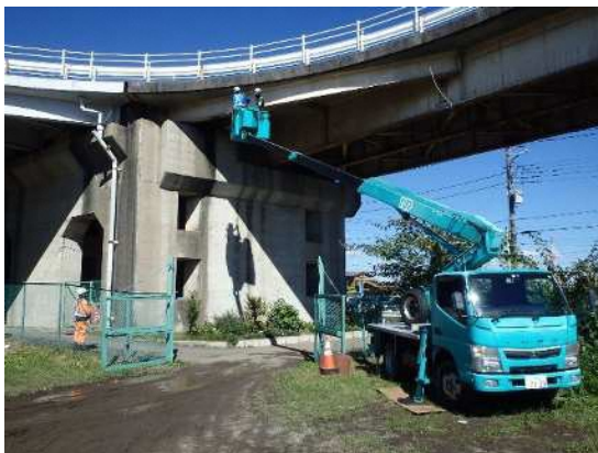
図7 橋梁の定期点検の実施状況
