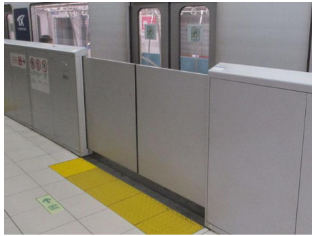
【転落防止用ホームドアの設置】
