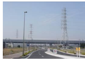
▼東京外かく環状道路
