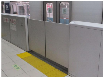
【転落防止用ホームドアの設置】
