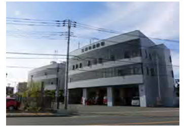
三郷市消防・防災総合庁舎
