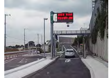
三郷料金所スマートインターチェンジ
