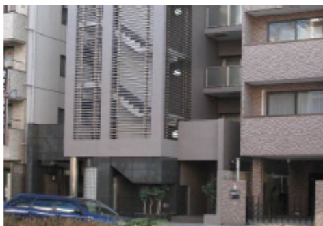
▲ルーバー等で囲い、外部に露出しないように配慮【新宿区】
