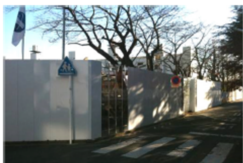
▲障壁の中の様子が一部見える工夫【横浜市】
