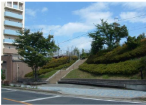
▲低木・中木を配した法面の緑化【三郷市】
