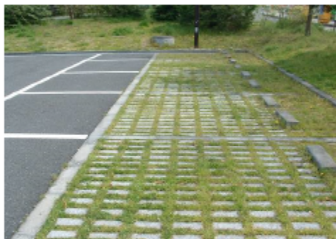
▲駐車場舗装面の緑化【三郷市】
