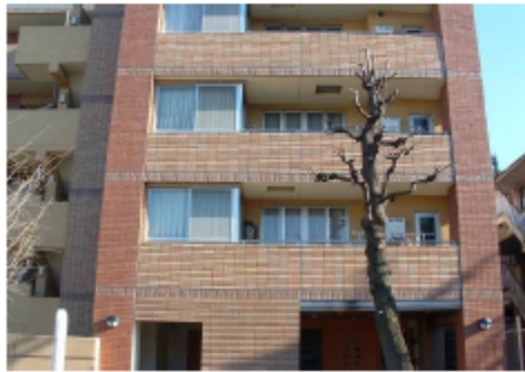
▲建築物本体と仕上げを合わせるとともに色彩の調和に配慮【川崎市】
