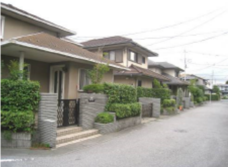
▲高さ・軒先の連続性の確保【三郷市】
