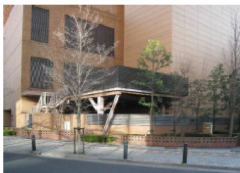
▲設備類が見えないように目隠しフェンス等で遮蔽【新宿区】
