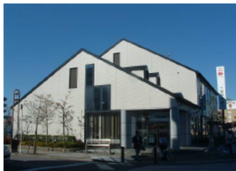
▲調和のとれた屋根勾配【千葉市】
