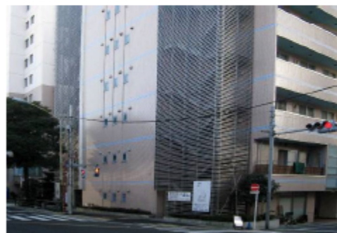
▲ルーバーで囲い、外部に露出しないように配慮【新宿区】
