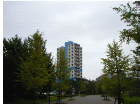
みさと団地の高層棟 周辺は空間的にゆとりがあり、緑も多い。
