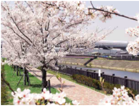
三郷放水路 江戸川と中川を結んでおり、水路に沿って桜並木が続いている。
