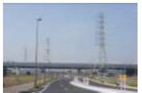
▼東京外かく環状道路
