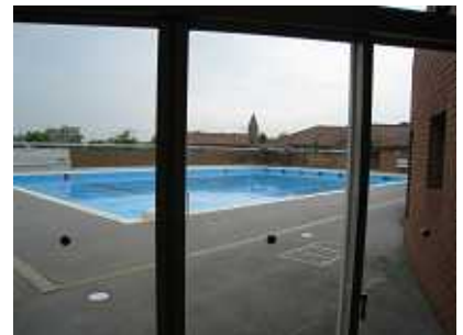
校舎内プール
