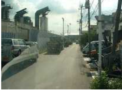
新和の工業施設2
