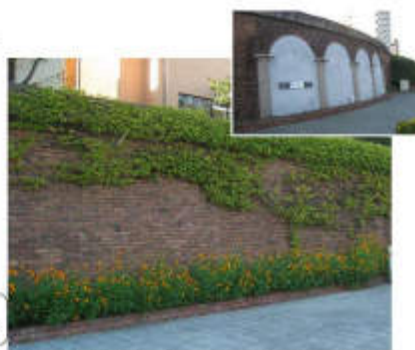
▲擁壁の表面処理をレンガ等の自然素材とし、車道にならないよう特徴的に装飾している／中央区（右上） 【図10】
