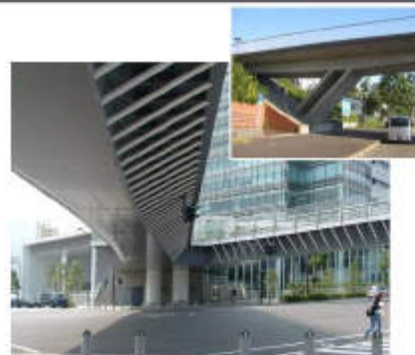
▲桁の形状を工夫し、圧迫感を軽減している／横浜市 橋脚と桁を一体的な構造とし、デザイン性を持たせることで圧迫感を軽減させている／多摩市（右上）【図. 図.】
