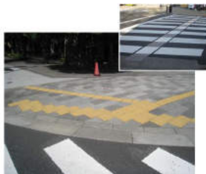
▲やわらかい印象の縁石で境界部の段差を解消するとともに誘導ブロックを設けている／千代田区【①、②、③】 歩道から横断歩道にかけて連続して誘導ブロックを設けている／日野市（右上）【④】
