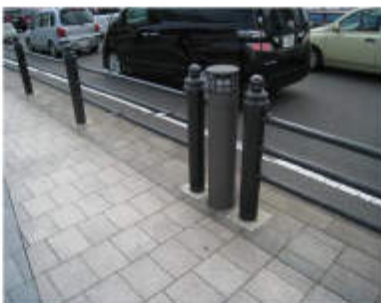
▲ポールの色を周辺と調和する色としており、通行の阻害にならない場所に設置している／横浜市【05】、【06】
