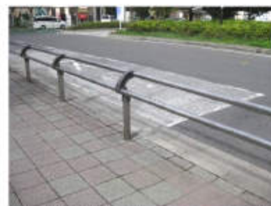
▲上欄を車道側に上げたすっきりとしたデザインで、歩道を広く感じさせている／川口市【02】
