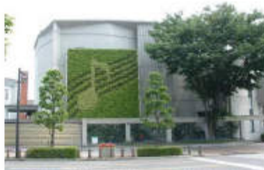
▲施設用途を壁面緑化のデザインに取り入れている／高崎市【09】
