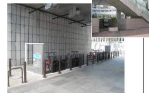
▲桁の下空間を駐輪場として活用している／横浜市 階段下の空間を喫煙所として活用している／横浜市（右上）【図. 図.】
