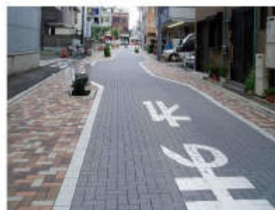
▲落ち着いたある低彩度のインターロッキングを複数組み合わせ、歩車道の路面の表情をつくっている／高崎市【⑬】
