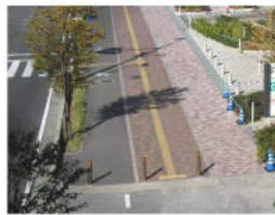
▲舗装区分により歩道と自転車道の機能分担をしている／越谷市【⑨、⑩】
