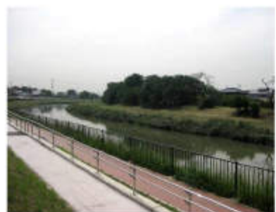
▲擁壁・護岸周りに転落防止柵を設置している／越谷市【図11】
