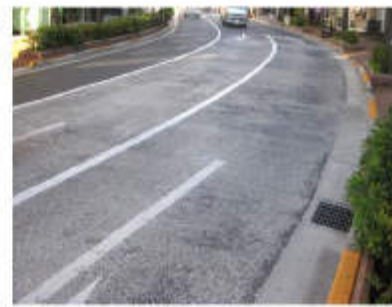
▲黒のアスファルト舗装と灰色の透水性アスファルト舗装により対向車線が区別されている／三鷹市【⑪】
