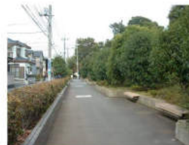
▲ 境界部に休憩スペースを設けている／三浦市【⑫】
