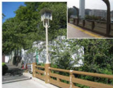
▲周辺地域の特性を踏まえた形態・色彩とし、橋の構造を活かして照明灯を設置している／千代田区【図. 図. 図.】 新橋を防護柵と一体的なデザインとしている ／成田市（右上）【図. 図.】
