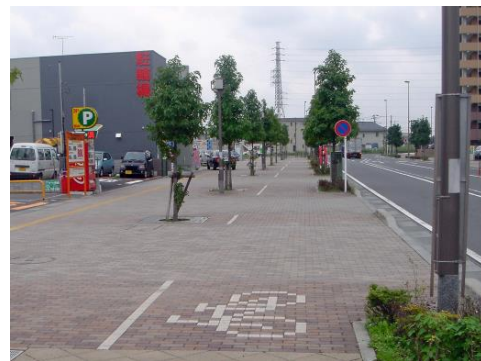
電線類の地中化（三郷中央駅周辺）
