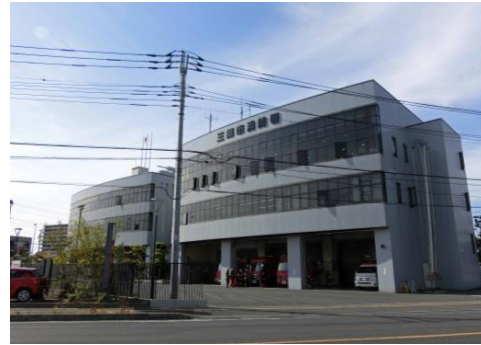
三郷市消防・防災総合庁舎
