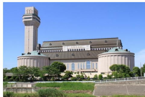
東埼玉資源環境組合第一工場ごみ処理施設
