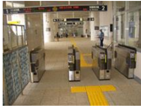
車いすに配慮した改札口（三郷中央駅）
