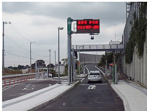
三郷料金所スマートインターチェンジ
