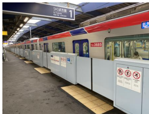
可動式ホーム柵（ホームドア）
