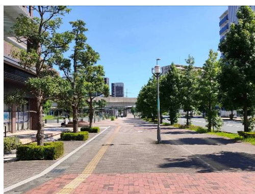
電線類の地中化（三郷中央駅周辺）
