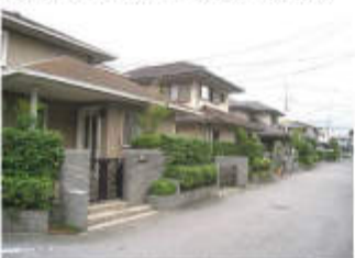
▲高さ・軒先の連続性の確保【三郷市】
