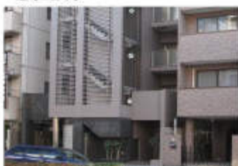
▲ルーバー等で囲い、外部に露出しないように配慮【新宿区】
