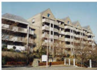
▲両辺との調和に配慮した屋根【多摩市】
