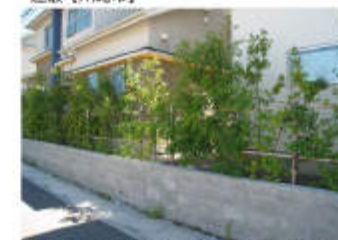
▲生垣による設備機器類への遮蔽【三郷市】
