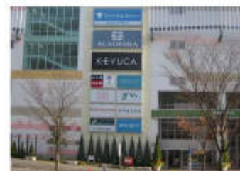
▲付帯広告物の集約【横浜市】
