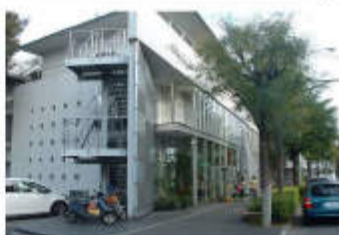
▲道路側から屋外階段が直接見えにくいように配慮【渋谷区】
