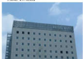
▲屋上設備機器類の遮蔽【立川市】
