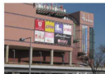
▲付帯広告物の集約【横浜市】
