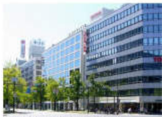
▲高さの連続性の確保【大阪市】
