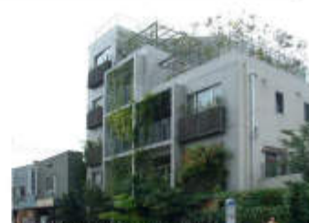
▲住居施設の壁面及び屋上緑化【世田谷区】
