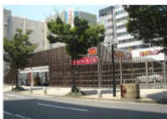
▲駐車場をルーバーにより遊蔽【神戸市】
