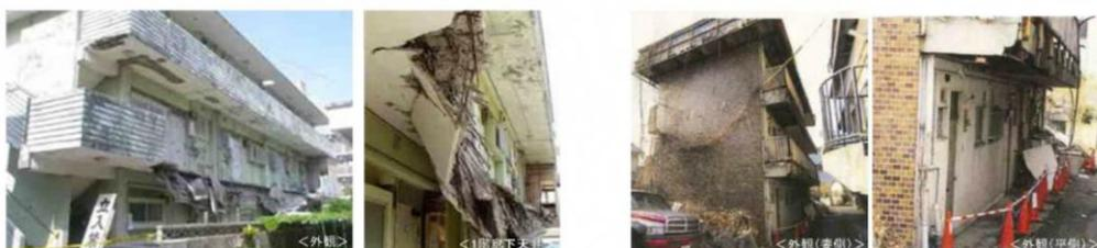
マンションの2階廊下部分が崩落した事例
