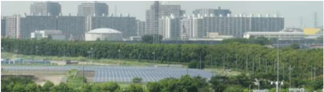
埼玉県中川水循環センターの外周部の植樹帯
