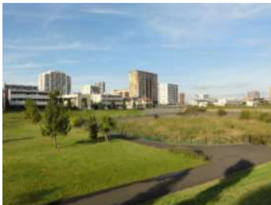
調節池を活用した栄調節池多目的広場
