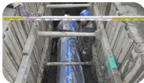
基幹管路更新工事の様子
