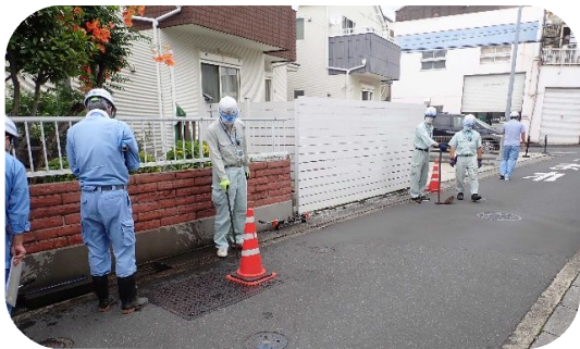
八潮市連絡管定期点検の様子
