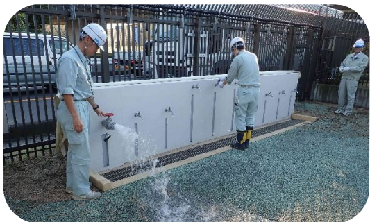
東京都水道局三郷浄水場内の応急給水区画使用訓練の様子
