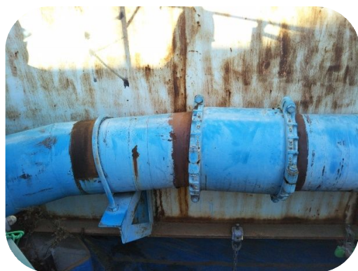
北側道橋添架管(左:補修前、右:補修後)
