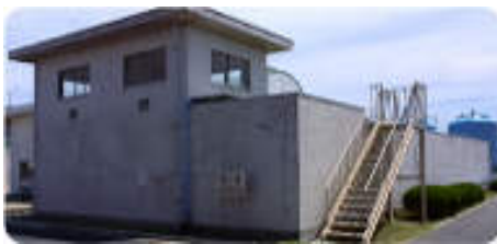
着水井・塩素混和池
